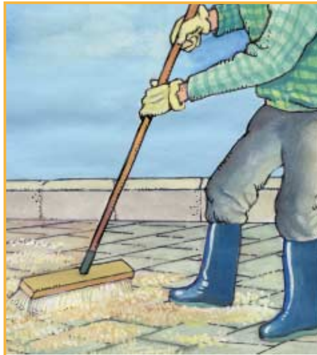
Eliminar el exceso de arena con cepillo.
